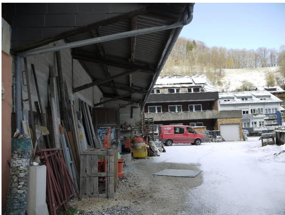
Abb. 6: Gebäude mit Nischen für Vögel und Fledermäuse.
